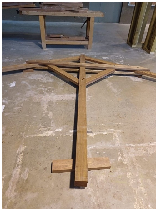
Foto 33 - Telhado parafusando e montagem das estruturas.
